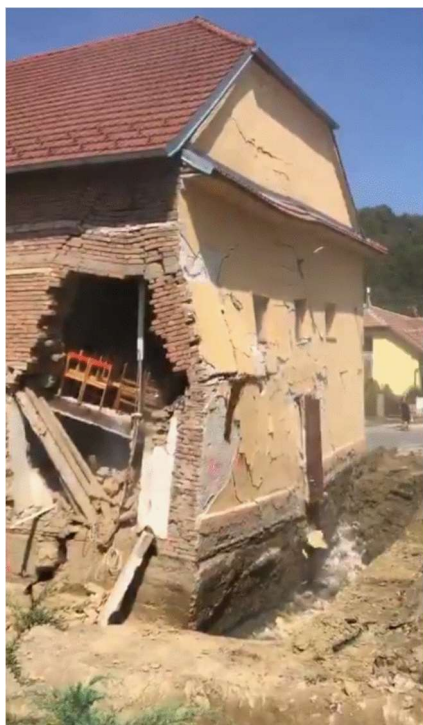
Obr. 31 Snímky z videa [6]. Uvolnění stropních nosníků galerie.
