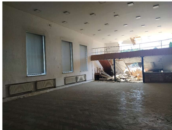
Obr. 54 Pohled na zbytky galerie
