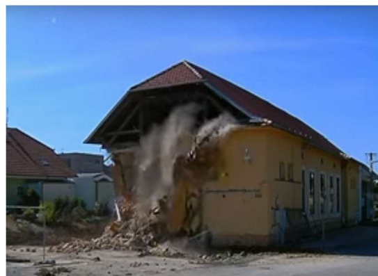
Obr. 36 Snímky z videa [7]. Pád zdiva v horní části štítu.
