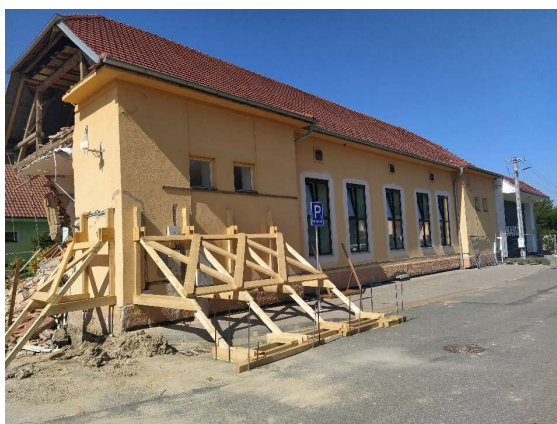
Obr. 55 Provizorní zajištění uliční stěny provedené IZS
