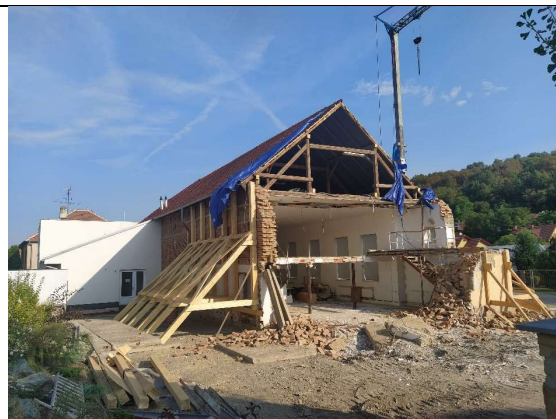
Obr. 58 Pohled na dočasné zajištění místa havárie. Zasypan výkop podél podélné stěny, provedeno zapření stěny. Odstraněna část střechy, zdiva a galerie.
