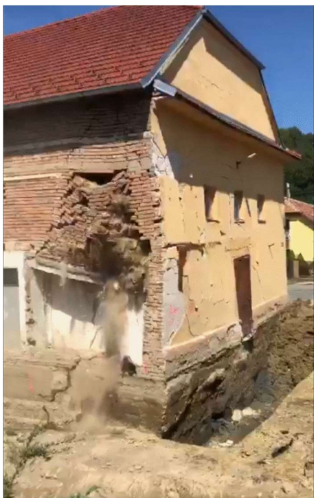
Obr. 29 Snímky z videa [6]. Uvolnění překladu z uložení, havárie zdiva, narušení horního věnce.
