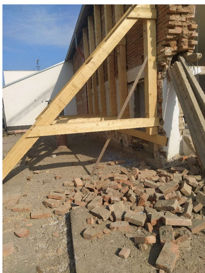
Obr. 67 Dočasné zajištění nádvorní zdi po provedení betonáže v úrovni základů a zasypání
