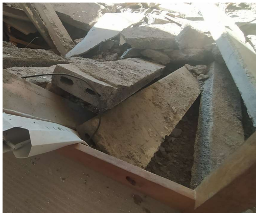
Obr. 53 PZD desky z konstrukce galerie
