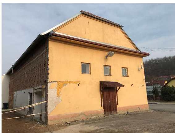
Obr. 17 Pohled na štít, vlevo již byla zbouraná přístavba
