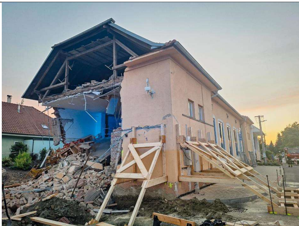
Obr. 26 Zajištění objektu záchrannými složkami, zdroj https://www.hzscr.cz/
