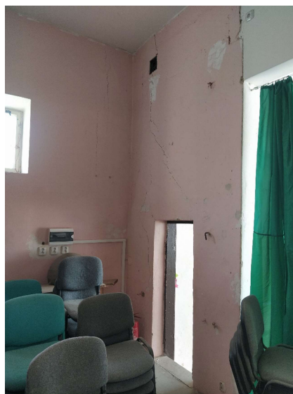
Obr. 66 Šikmé trhliny v příčné i podélné stěně v prostoru podia, směr ulice
