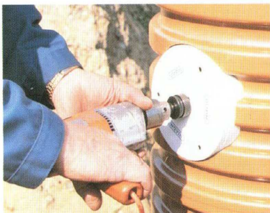
Montáž vložky in-situ
