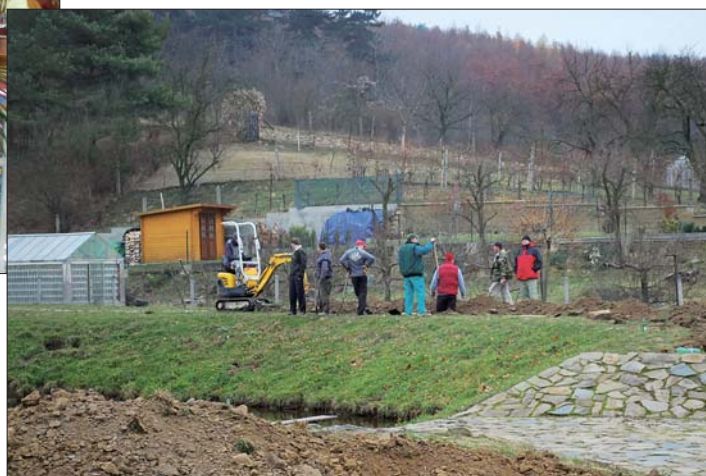
Práce na osvětlení retenční nádrže
